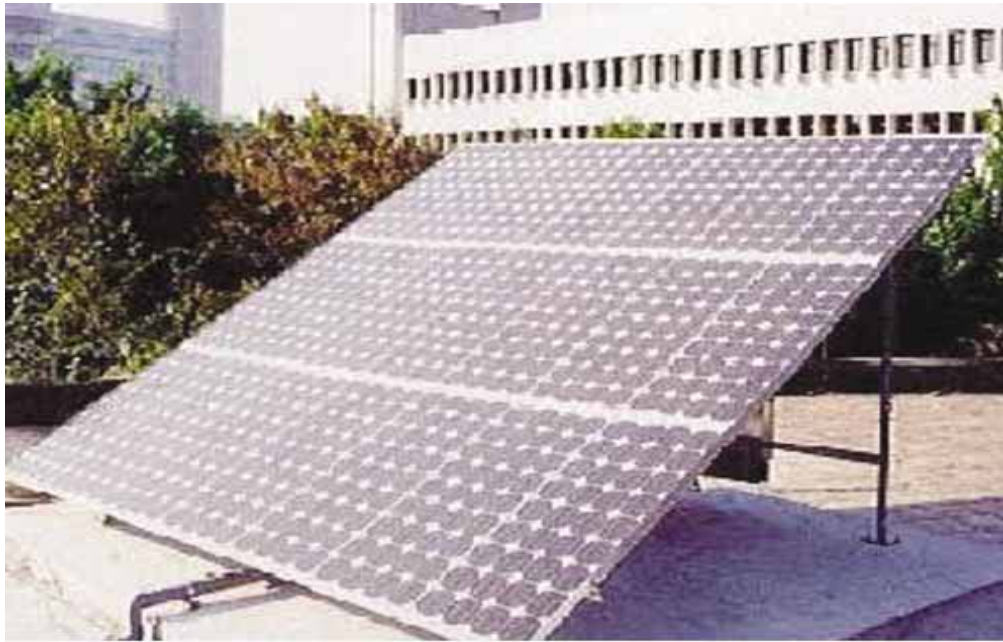
太陽能光電收集器，通常用的是矽單晶半導體二極體，也可以用其他的半導體材料。把這些光電片串聯，可以得到較高的電壓；並聯可以產生較大的電流。如何提高每片收集器的太陽能利用效率，是科學家努力的重點。
